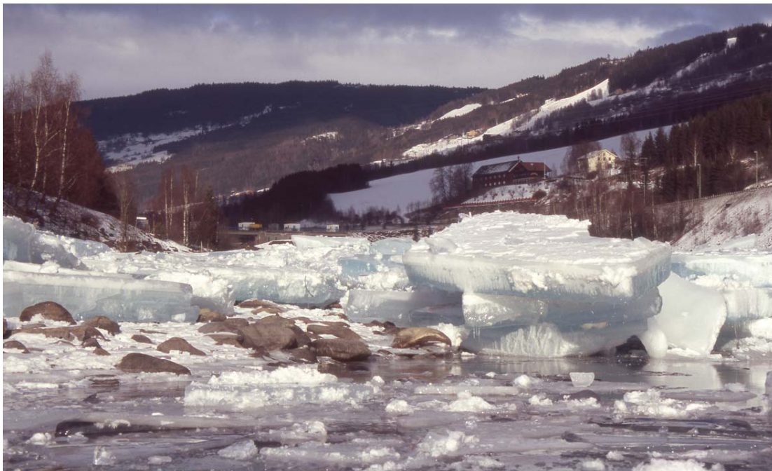
Bilde: Rester av isgang i forbindelse med turbinutfall i Hunderfossen kraftverk. Store isblokker brytes løs fra kulpene ovenfor gytfeltet og stuves sammen og skurer ned i gytgrusen som følge av sammenpressing mellom to brupillarar ved jernbanebrua. Bildet viser ismasser på gytfeltet kort tid etter en episode i februar 1996 (foto: Morten Kraabøl).
